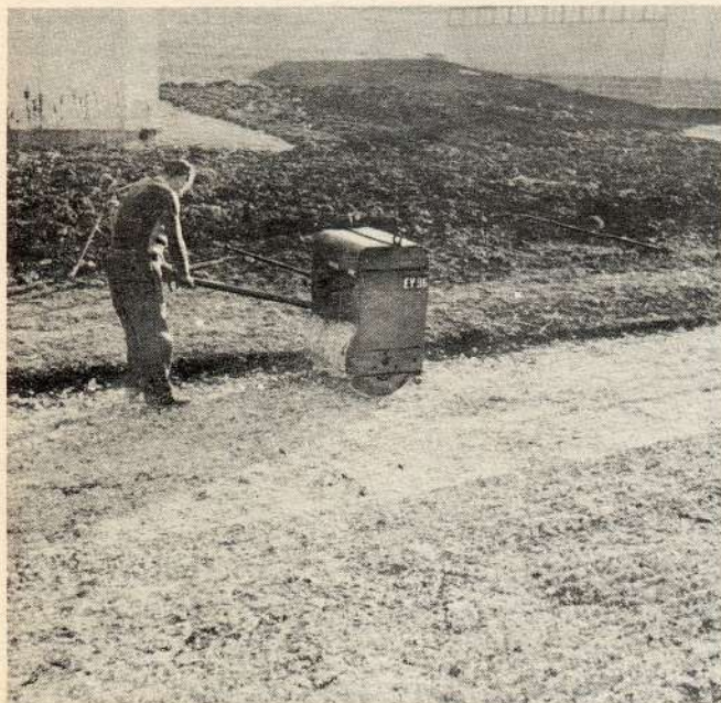
PRÉPARATION DE LA FONDATION
