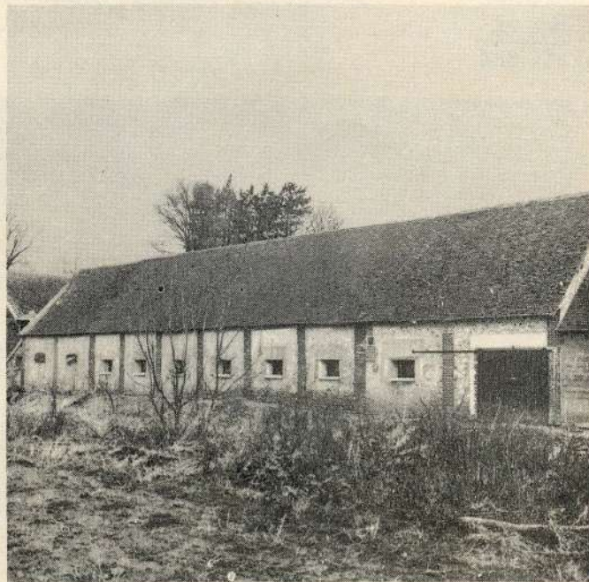
EXTÉRIEUR NOUVEAU ( Côté Ruisseau )
