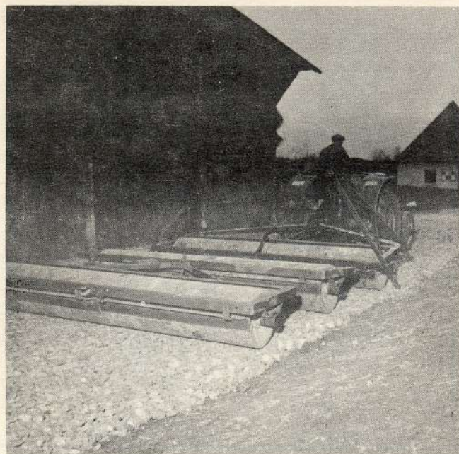
MISE EN PLACE DU SQUELETTE PIERREUX
