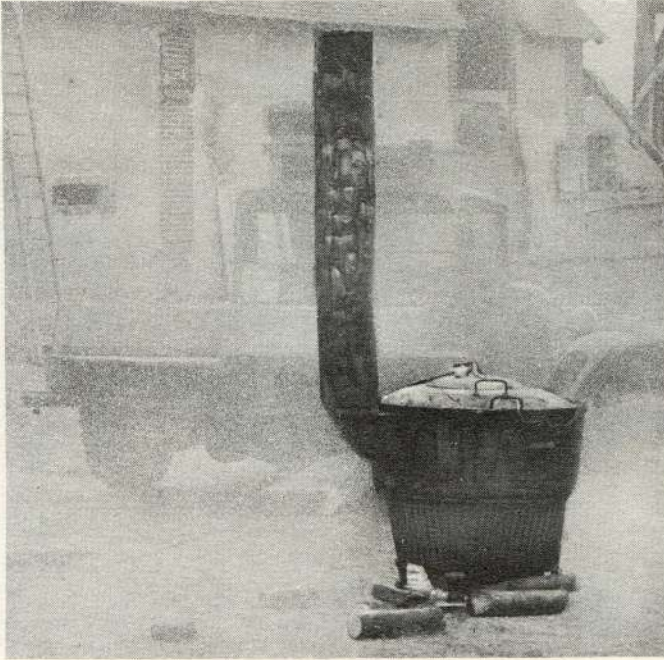
MARMITE AGRICOLE ( préparation du mastic )
