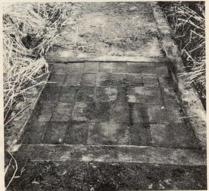
COULOIR D'EVACUATION D'ETABLE
